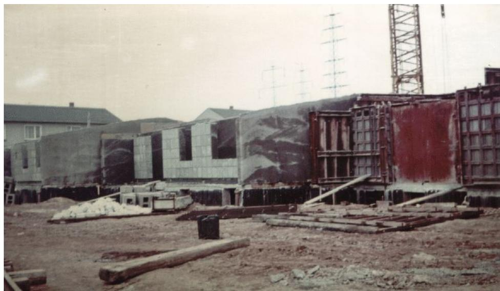
Abb.16: Bungalow in der Bauphase in AF (rechts noch eingeschalt)
